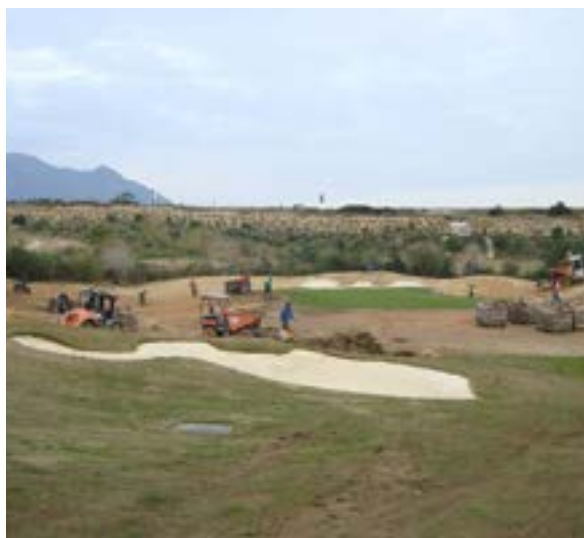
Colocación de tepes de Bermuda en un antegreen.
